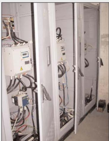
На ЦТП-10 УПП установлены и на вентиляторах и на дымососах. на фото справа общий вид ЦТП-10 и частотные преобразователи, установленные на двигателях насосов
