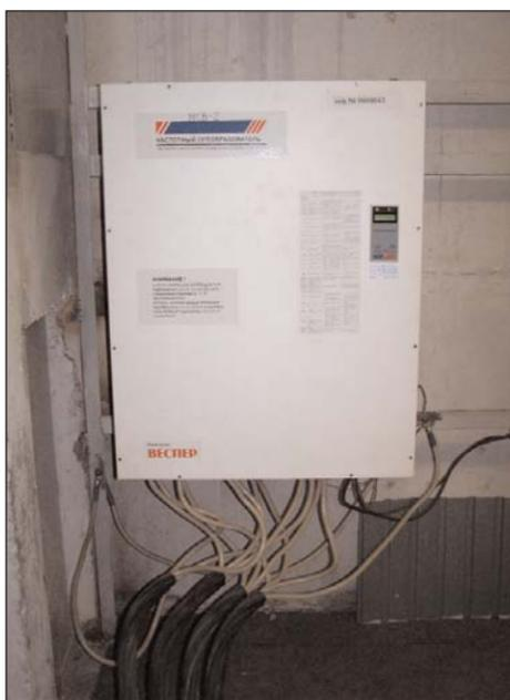
на Зареченской районной котельной установлено несколько частотных преобразователей на двигателях подпиточных насосов. А УПП работают на сетевых. На фото сверху частотный преобразователь "Веспер" мощностью 220 кВт
