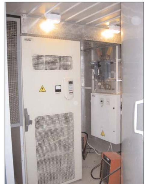
Мощность преобразователя 630 кВт, этого хватает, чтобы поддерживать заданное давление во все водопроводной сети города. На фото внизу система климат-контроля помещения, где установлен ПЧ
